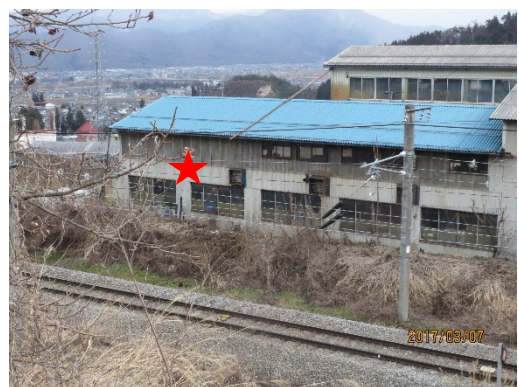
(有)唐沢の工場壁面 ★看板設置位置
